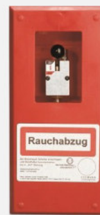
Abbildung 6 | beispielhaft pneumatische Auslöseeinrichtung für Rauch- und Wärmeabzüge, Beschriftung „Rauchabzug“, Farbe RAL 3000 [Quelle: www.essmann.de ]
